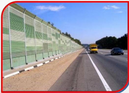
*Композитный шумозащитный экран на основе стекло- или базальтоволокна*
